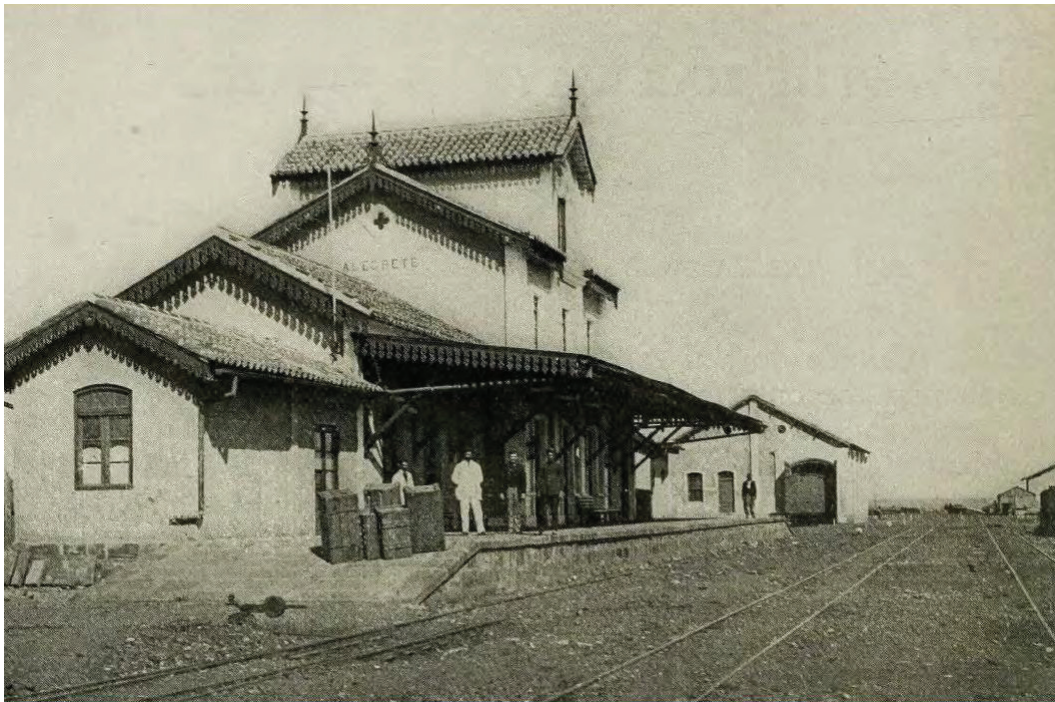
Figura 8: Estação ferroviária de Alegrete antes da reforma. Fonte: https://www.google.com/ . Acesso em: 19 abr. 018
