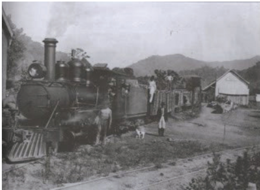
Figura 2: Primeiras Ferrovias do Rio Grande do Sul. Fonte: https://www.google.com/ . Acesso em: 19 abr. 2018
