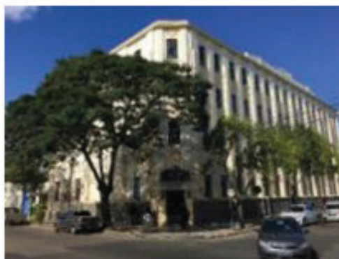
Figura 19: Edificação do Moinho Chaves, atualmente
