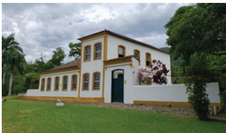
Figura 1 – Fachada do Museu casa dos Açores, Biguaçu/SC.
