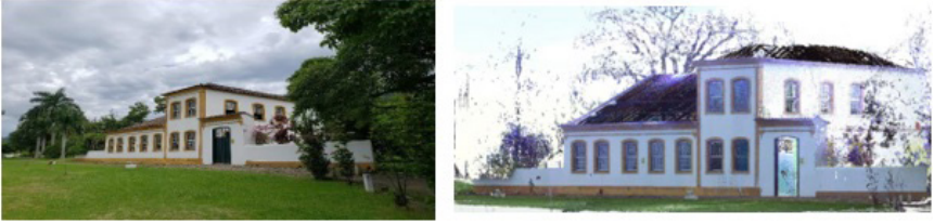
Figura 3 - Comparação entre a foto do Museu Etnográfico Casa dos Açores e escaneamento do imóvel por nuvem de pontos
