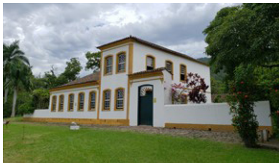
Figura 1 – Fachada do Museu casa dos Açores, Biguaçu/SC.
