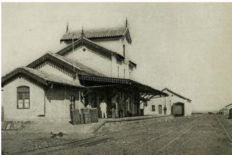
Figura 8: Estação ferroviária de Alegrete antes da reforma. Fonte: https://www.google.com/ . Acesso em: 19 abr. 018
