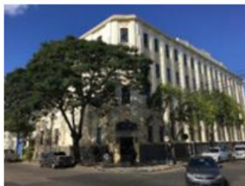
Figura 19: Edificação do Moinho Chaves, atualmente
