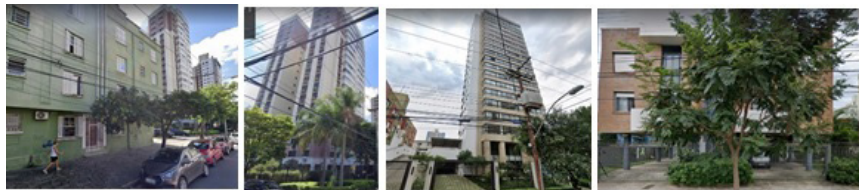
Figura 1: Prédios próximos de características heterogêneas no Bairro Menino Deus em Porto Alegre
