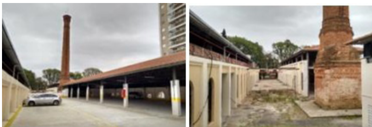
Figuras 4 e 5: Empreendimento Rossi FIATECI, área de estacionamento e futura área comercial, respectivamente. Pavilhões com alteração na altura do telhado
