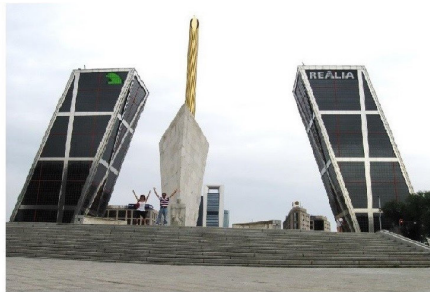
Edifícios gêmeos – Madri-ES. Fotos do autor
