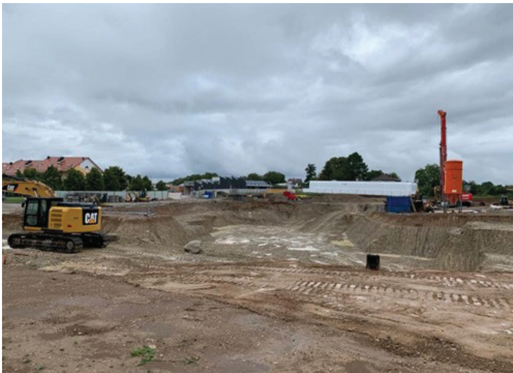
Image 2 - Chemin de Saint Mathieu à Bernex (après les fouilles)
