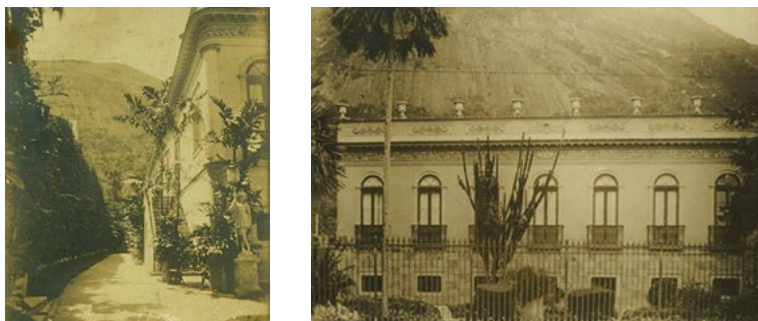
Figura 4: Registro da residência da família Oliveira Castro antes de ser demolida na Rua São Clemente, atual número 398, no bairro de Botafogo, Rio de Janeiro – RJ
