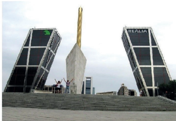
Edifícios gêmeos – Madri-ES. Fotos do autor
