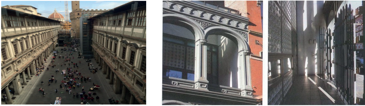
Figura 1: Vão interno da Galeria Degli Uffizi - foto da autora e Edifício em NY - Fonte: BOLLACK 2013, p.29)
